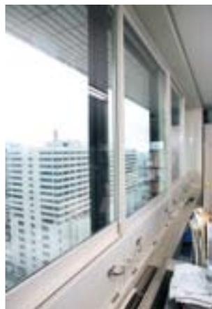
具体的な工事は、合同庁舎5号館の23階（地球温暖化対策課、総務課、地球環境局長室）と26階（廃棄物・リサイクル部）の既設の窓（単板ガラス＋アルミサッシ）の内側に、高性能複層ガラスを装着した「樹脂サッシ（内窓）」を追加施工したもの
