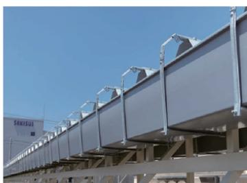
大型建物用大容量雨とい「超芯V-MAX」は、超延伸シートと塩ビ樹脂の3層構造で構成される業界最大級の大容量雨といです。
