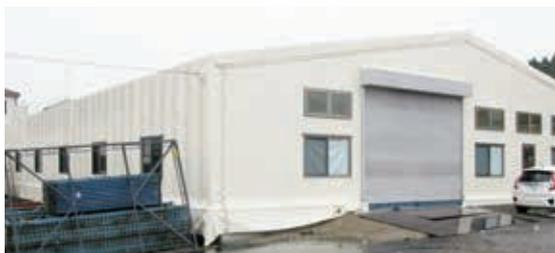
▲霞ヶ浦のほど近くに建つ茨城工場の中の縫製工場(2020年竣工)。奥行35m、幅20m、高さ4.5m。敷地面積700㎡の巨大なテントハウス。
