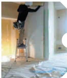
新築現場で施工される壁紙のうち、15%程度が施工端材、剥がし材などの廃材になる。
