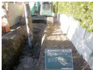
稲敷市西代地区での被災管撤去作業
