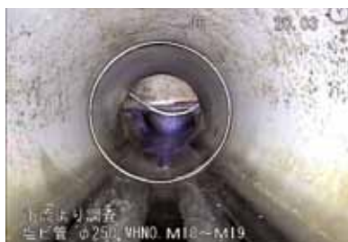
管路内の状況（洗浄後）
