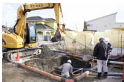
日の出地区における下水道の復旧作業
