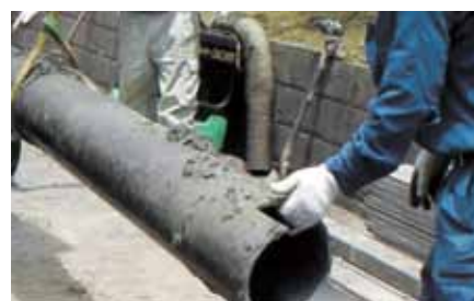
埋設管掘り出し作業の様子
