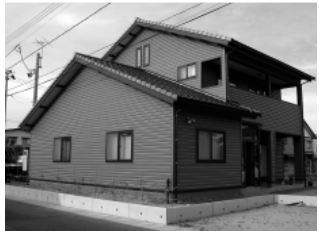
塩ビサイディングによる外張り断熱の新築住宅(鶴岡市)
