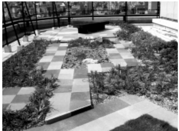
塩ビ壁紙リサイクルブロックを敷き詰めたクアトロ室町ビルの屋上庭園
