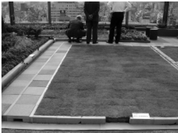
台東区役所「エコガーデン」(敷石・緑石が塩ビ壁紙リサイクルブロック)
