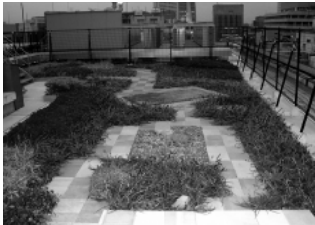
敷石や縁材に利用される塩ビ壁紙のリサイクルブロック
