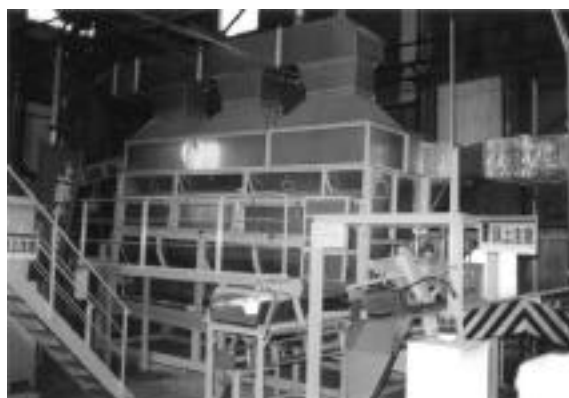
実証プラント
