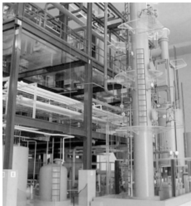
写真：プラスチック油化処理装置
