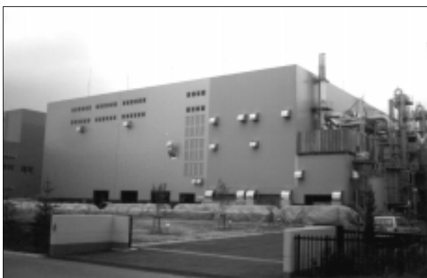
写真：札幌プラスチックリサイクル(株) 油化処理施設
