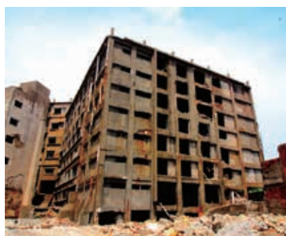
劣化が進む日本最古の鉄筋コンクリート30号棟 © 2018 野口貴文
