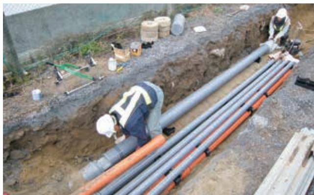
電線共同溝ケーブル保護管の敷設作業の様子
