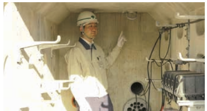
地中化工事でケーブルを格納する特殊部の様子。 （東京都PR動画 https://www.youtube.com/watch?v=q62RaaC3cE0&t=5s からの引用。）
