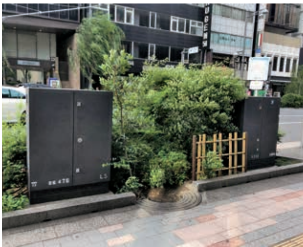
電線の地中化後に設置される地上機器。
