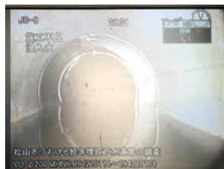
▲長期にわたって使用された塩ビ管の、新たな性能評価方法として、プロファイラ調査（写真上）とTVカメラ調査（写真下）を実施。
