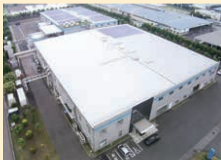
ライフイン環境防災研究所の全景
