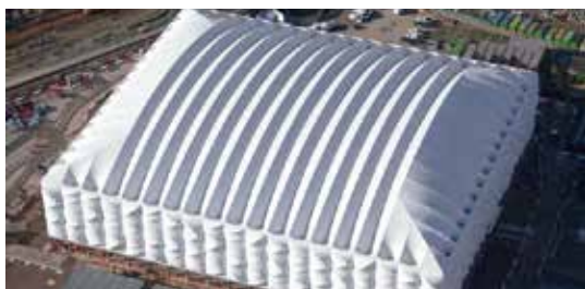
バスケットボール競技場 (画像提供 LOCOG)。PVCは、建物全体の外部構造となった。
