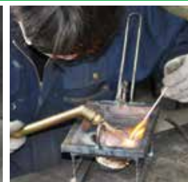
④ ロウを溶かして溶接
