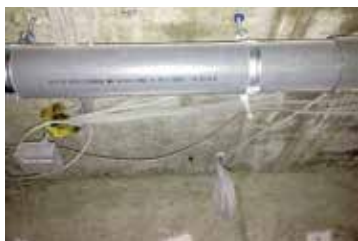
宮城県の復興住宅に施工された大水の再生管
