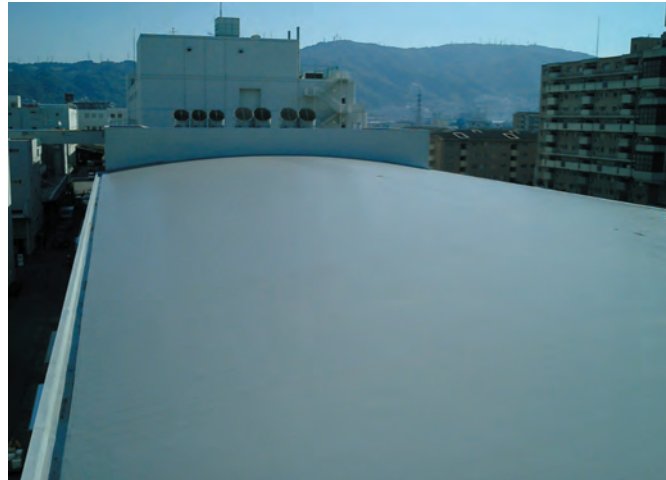
屋上防水シート
